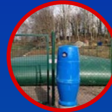
Citerne, réserve incendie
